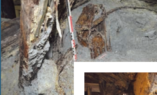
Détail d'un auget de la roue hydraulique.
