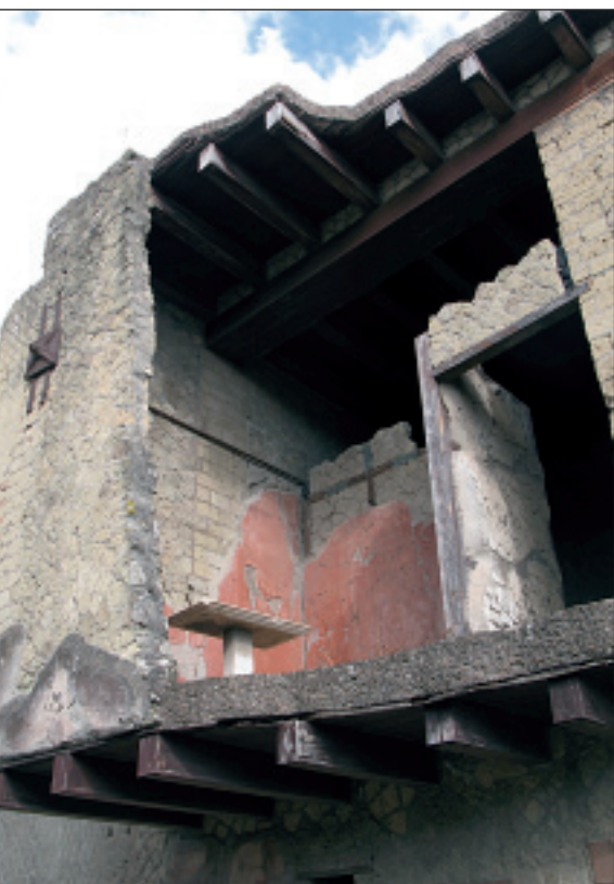
CI-DESSUS. Herculaneum, Casa di Nettuno e Anfifrite (V, 6-7). Vue de l'étage depuis la rue. Photo © M.-L. Maraval
