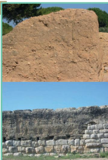
Ampurias (Espagne), I<sup>er</sup> s. av / I<sup>er</sup> s. ap. J.-C. Murs de maison en pisé et muraille de la ville en béton : transposition du processus technique d'un matériau à un autre (dichés C.-A. de Chazelles)
